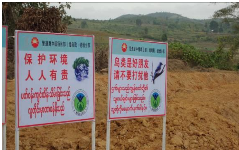
施工现场设置标语牌和警示牌，提醒人员注意环保
