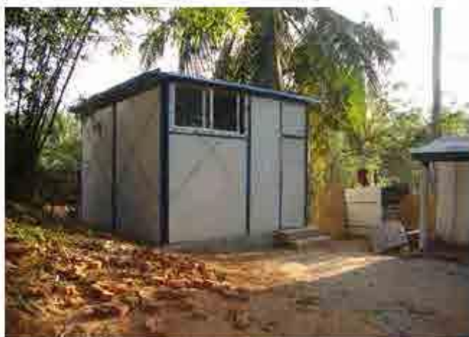
2012年1月8日，为岛上寺庙捐建了一座水冲厕所，方便寺庙僧人洗漱和使用。
